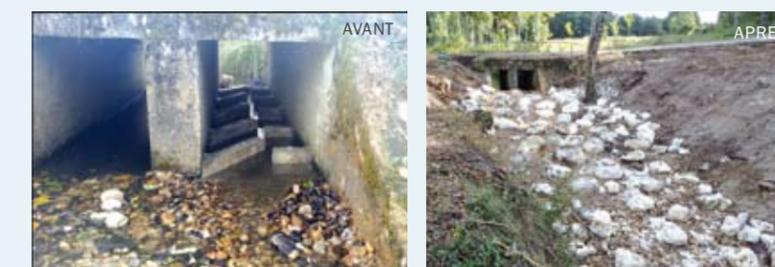
Rampe en enrochement à la fin du chantier ; Barrettes installées sur la radier du pont pour faciliter les déplacements.
