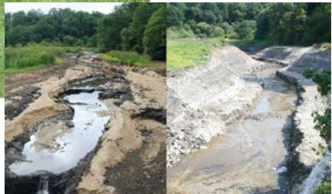
Les travaux visent à la fois à restaurer la morphologie du cours d'eau et à restaurer des écosystèmes d'eau courante au dépend des espèces d'étangs. Certaines nuisances liées à la retenue (eutrophisation, réchauffement de l'eau, évaporation) seront par ailleurs éliminées. Un nouveau souffle pour le Vincou !
