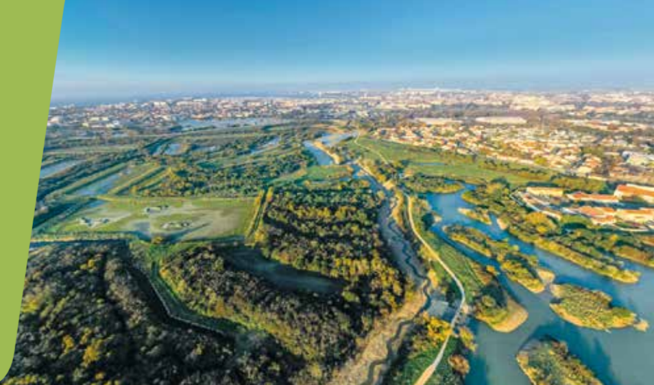
Le marais de Tasdon, après travaux de renaturation (Image : Ville de La Rochelle)
