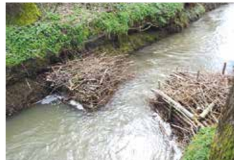
Exemple des techniques de génie végétal utilisées au début des travaux de restauration hydromorphologique de la Bonnière
