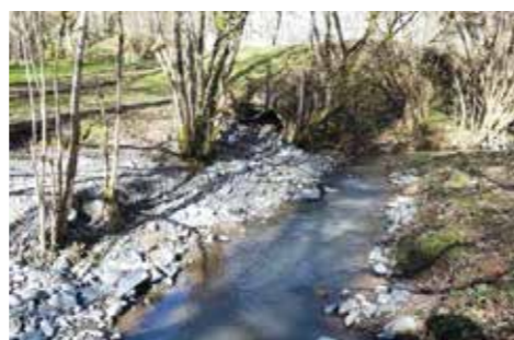
Exemple de recharge granulométrique pour remonter de manière pérenne la hauteur d'eau
