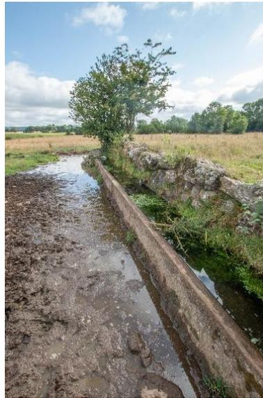
Figure 23 : Stagnation de l'eau du trop-plein au pied de l'abreuvoir (Bastien DACHET)
