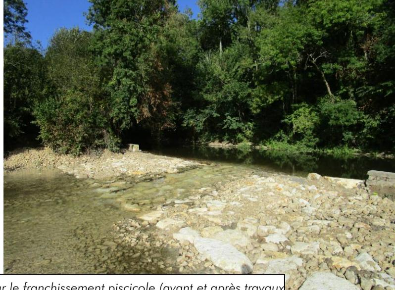
Implantation d'une rampe en enrochement pour le franchissement piscicole (avant et après travaux)
