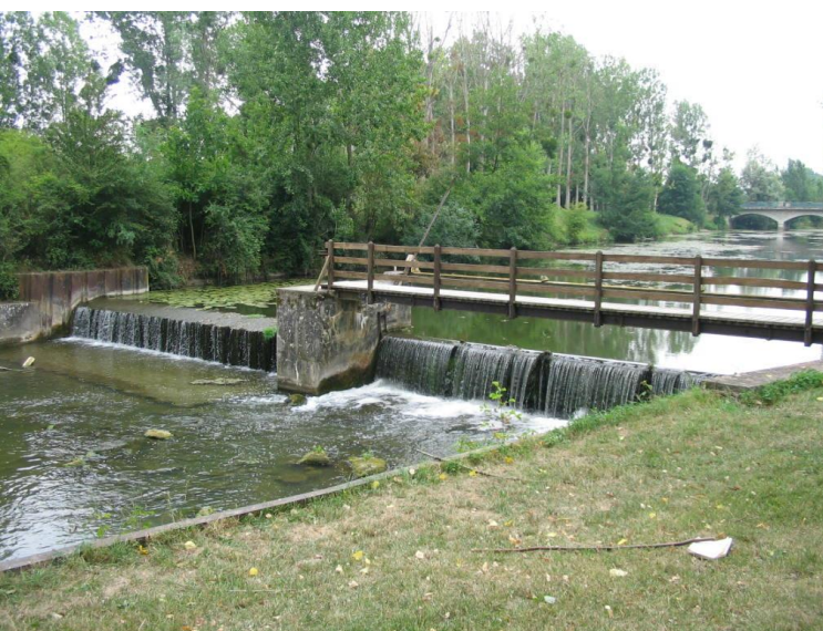
Photo avant travaux – vue du pont
