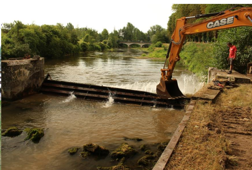
Photo après travaux – vue du pont
