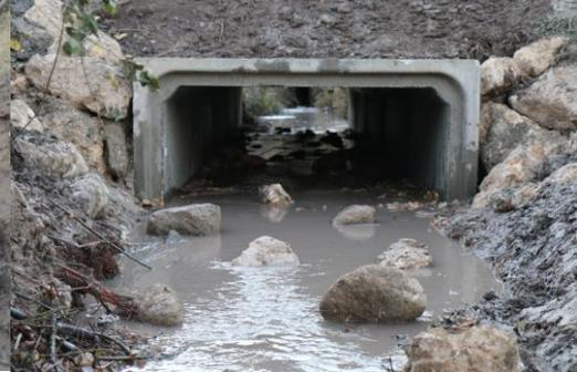
Sur le tronçon A10-voie ferrée :  $\Delta H_{max} = 0.17 \text{ m}$  ; Linéaire traité = 150 ml ; Pente moyenne = 0.13 %
