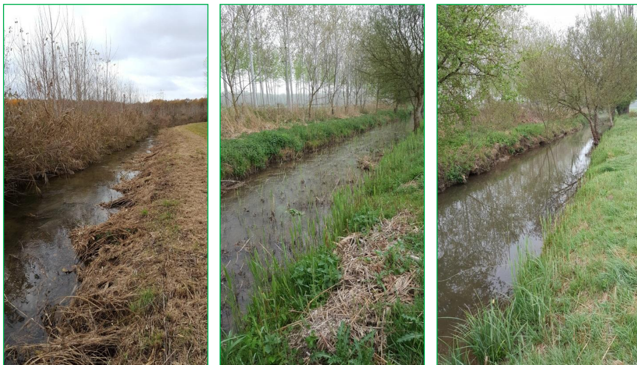
Photos avant travaux
