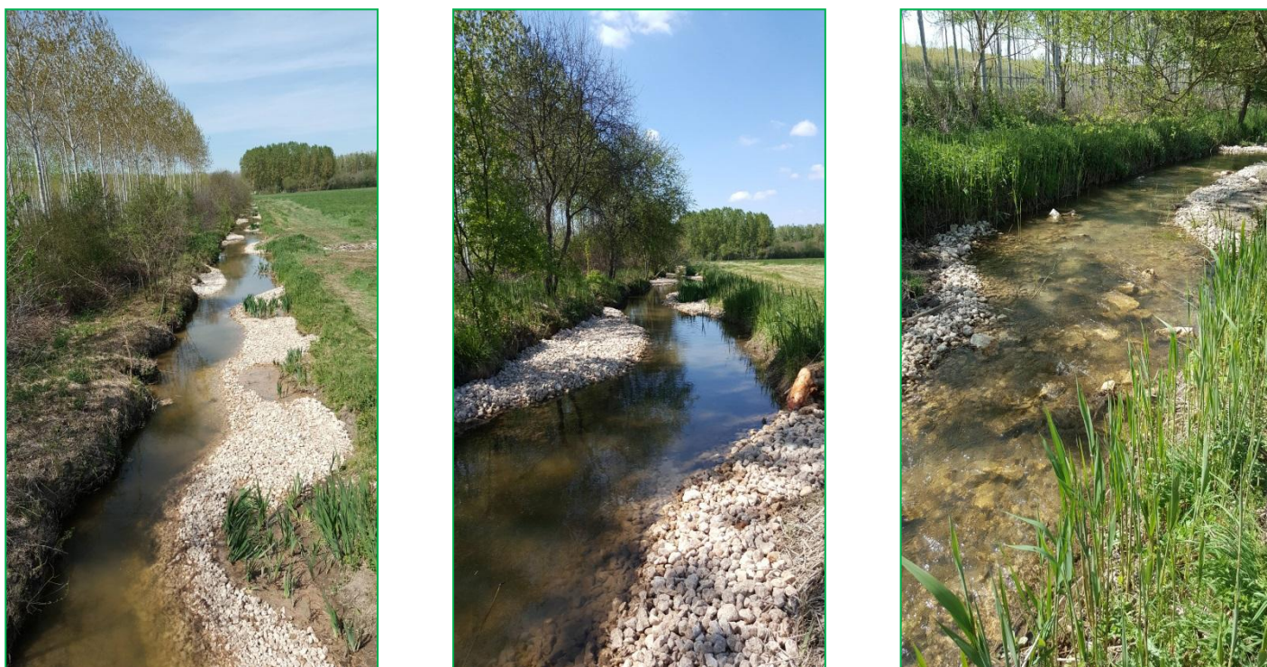
Photo après travaux
