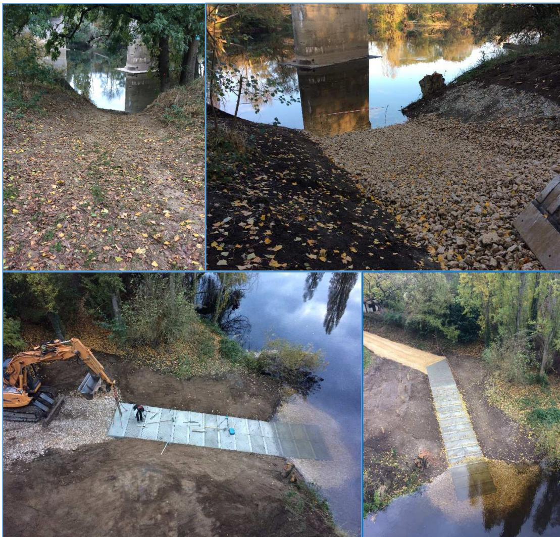
Figure 1: Illustration des travaux de création de mises à l'eau (exemple de la Guerche – 37)
