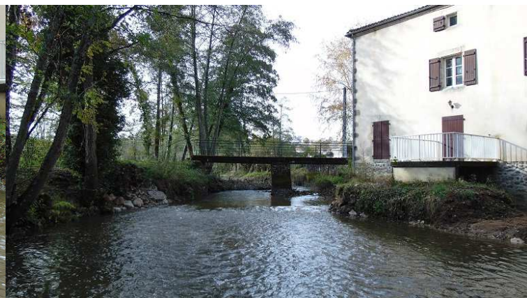
Photo après travaux
