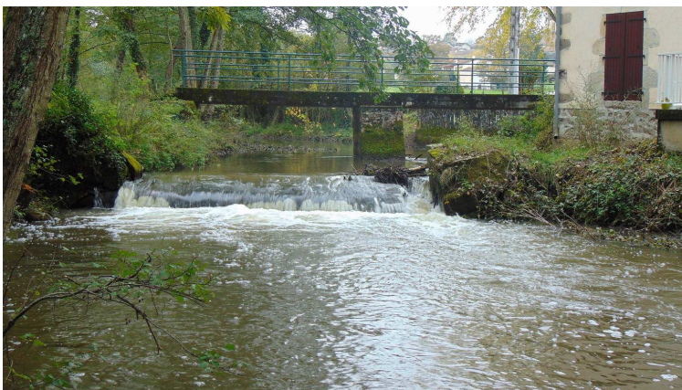
Photo avant travaux
