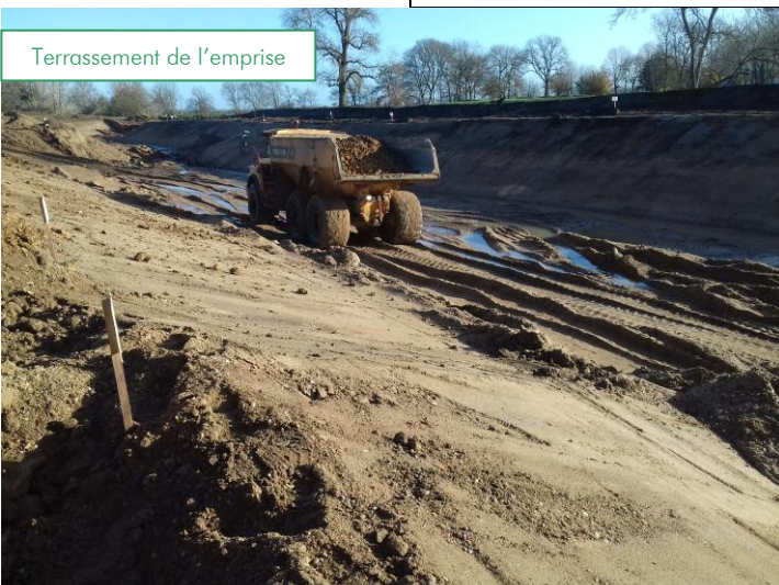
Pose des seuils bétons et enrochement des talus
