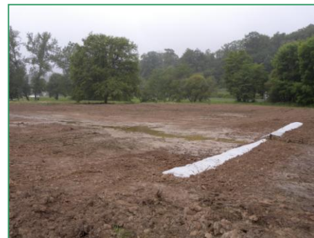
Réalisation du bassin aval de décantation (photo : SMVG)
