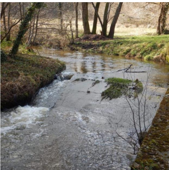
1- Seuil des Planches – Champagnac la Rivière (avant/après travaux)
