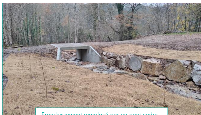
Franchissement remplacé par un pont cadre
