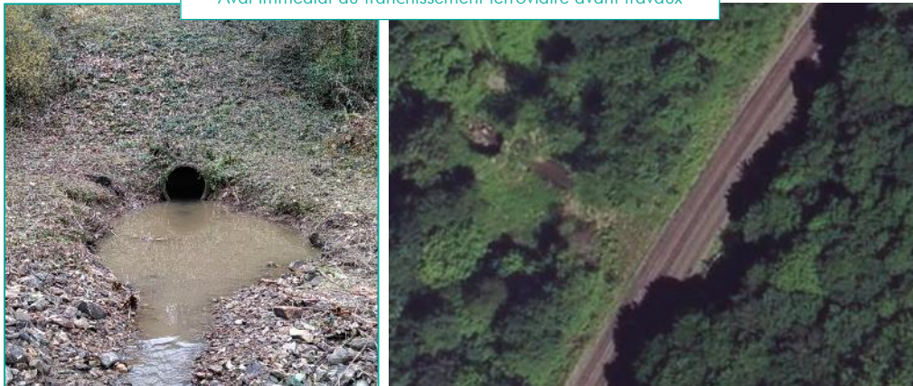
Aval immédiat du franchissement ferroviaire avant travaux
