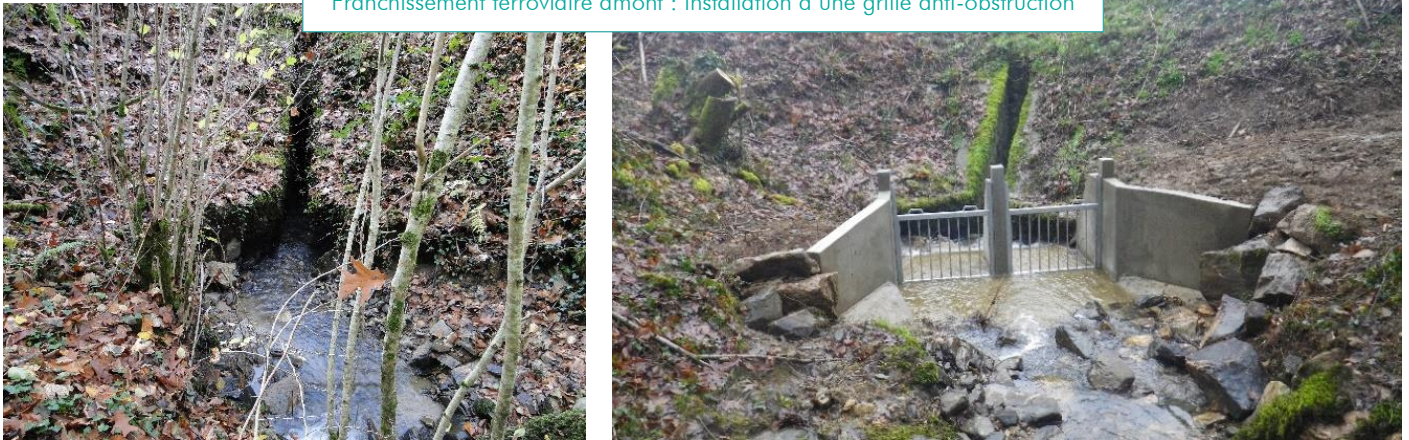
Franchissement ferroviaire amont : installation d'une grille anti-obstruction
