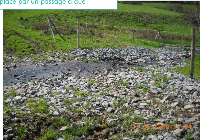
Franchissement busé remplacé par un passage à gué
