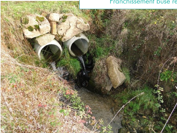
Franchissement busé remplacé par un passage à gué
