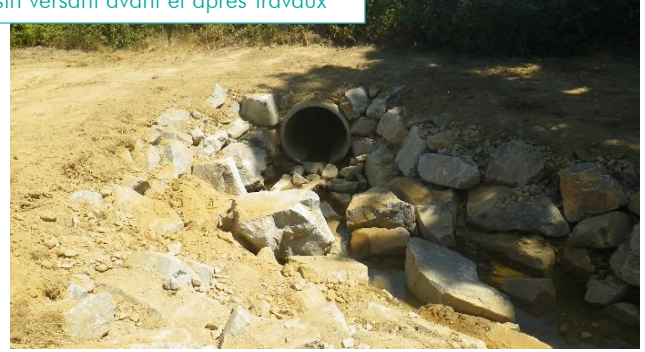
Exutoire du réseau pluvial du bassin versant avant et après travaux
