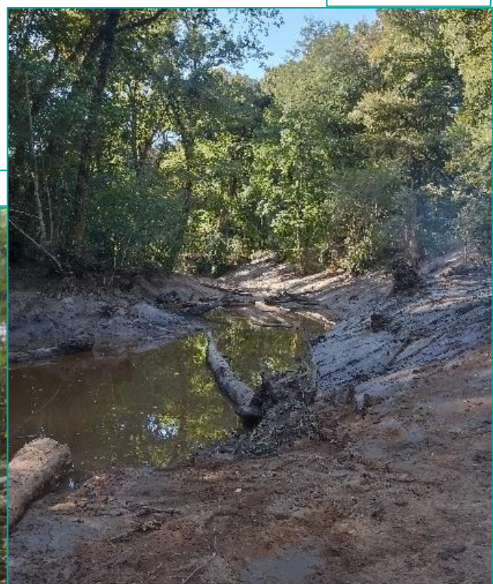
Aperçu après travaux
