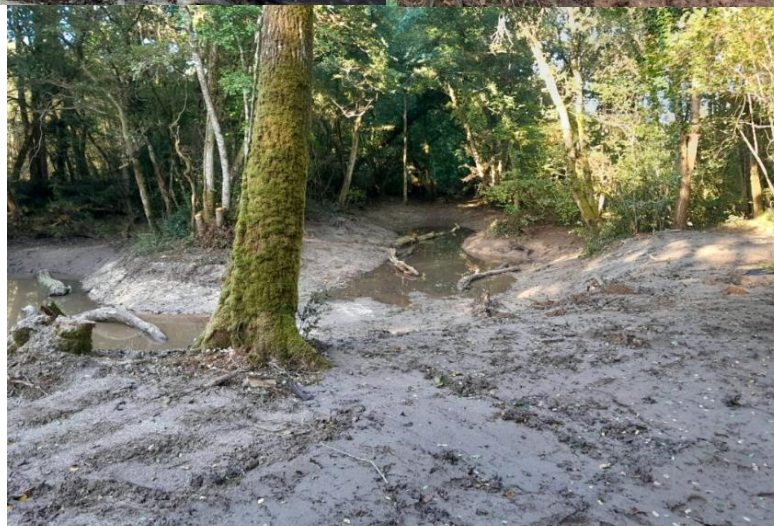
Terrassement de l'ancien bras
