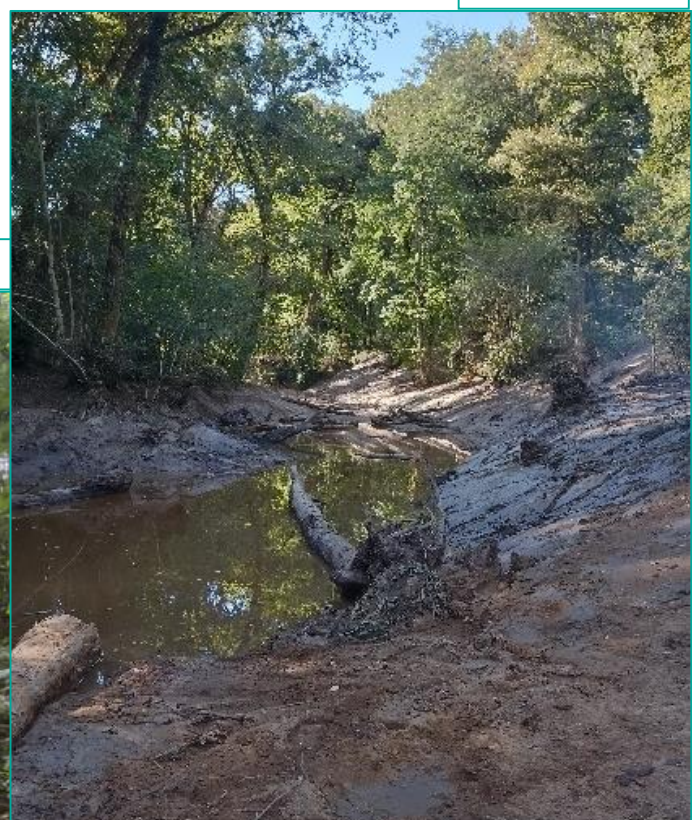
Aperçu après travaux
