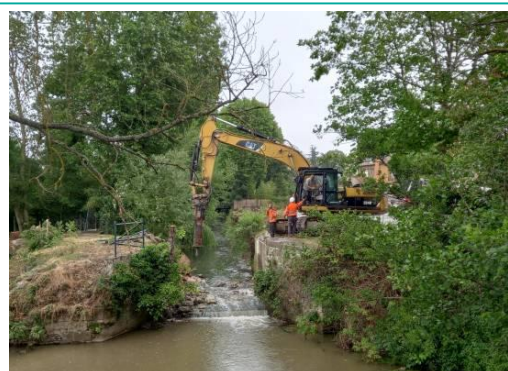
Dérasement de l'ouvrage
