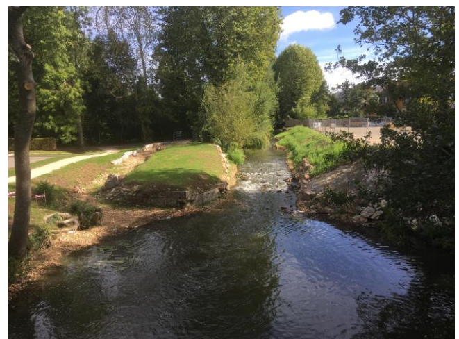
Photo après travaux
