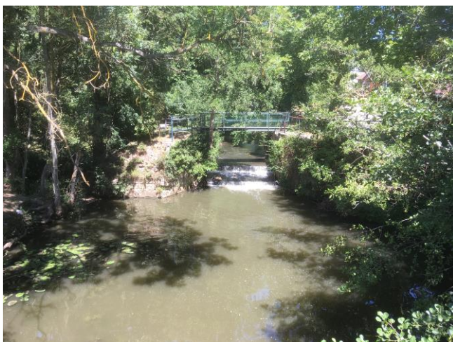
Photo avant travaux
