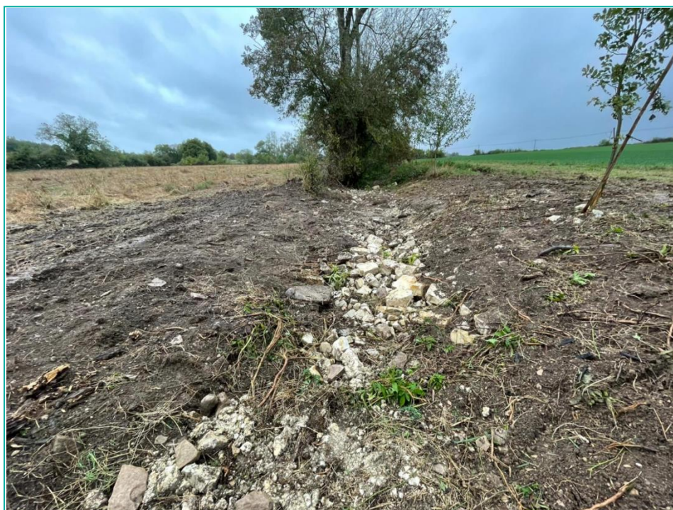
Recharge granulométrique et arasement du merlon en rive droite (à gauche sur la photo)
