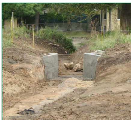
Batardeau et clôture (photo : SMVT)
