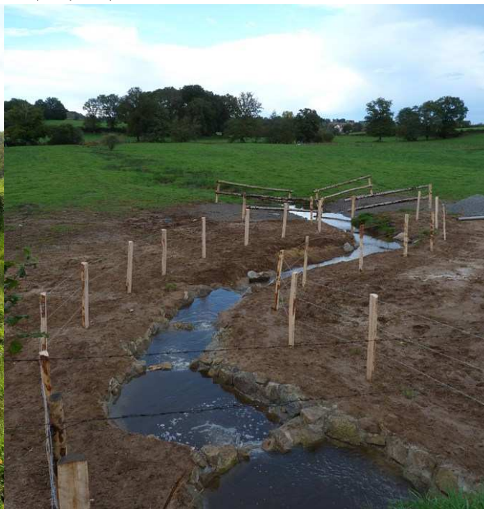
Vue depuis l'amont après travaux
