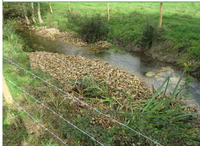
Après travaux – Banquettes alternées en granulats 35-120 mm
