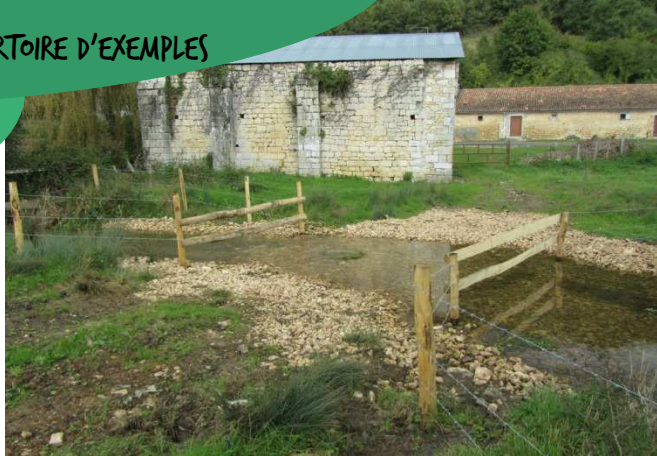
Après travaux – Mise en place de passage à gué
