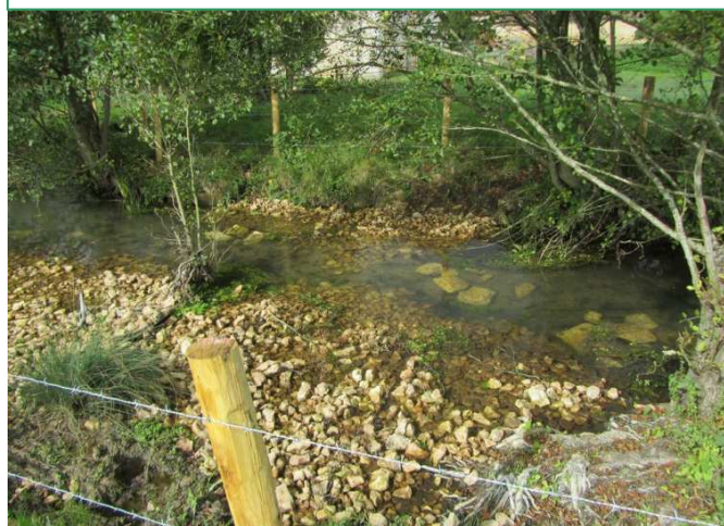
Après travaux – Recharge en granulats 35-120 mm et blocs
