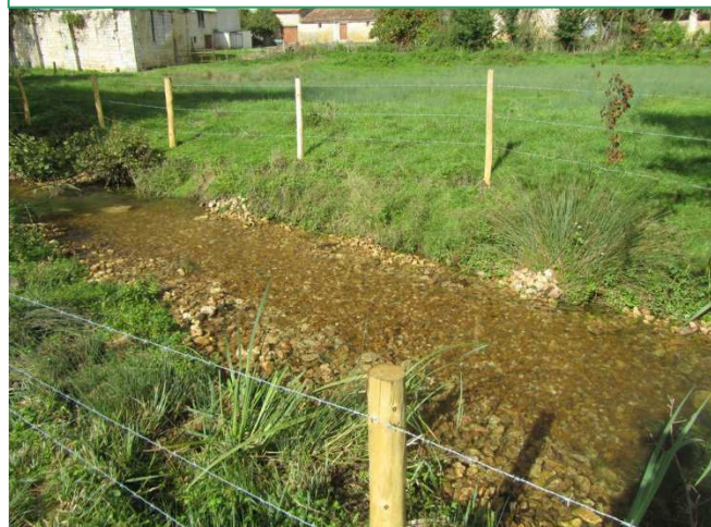
Après travaux – Mise en place de frayères à truite
