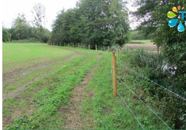
Après travaux – Mise en place de clôtures en fil barbelé
