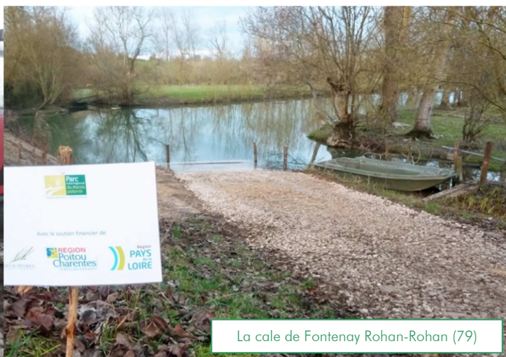
Aménagement de la cale de La Ronde (17)
