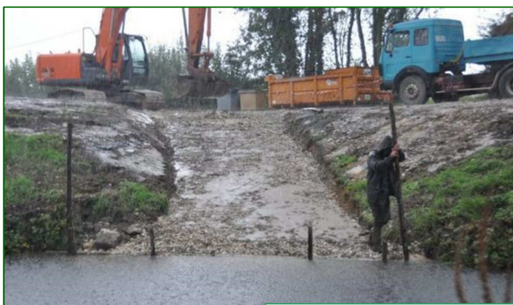
La cale des Essarts en chantier (79)
