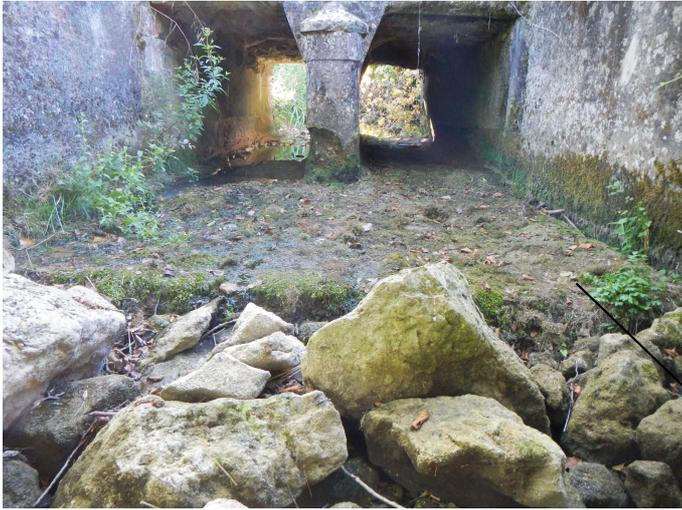
Juillet 2015 : prise de vue aval vers l'amont. Les blocs calcaires constituent la rampe en enrochement installée en 2014. Sous les arches du pont, les écoulements sont trop rapides et pénalisent la migration piscicole.
