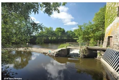
Ouverture permanente de vannes
