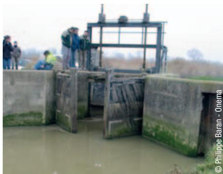
Portes à flot et vannage régulant les mouvements d'eau en estuaire.
