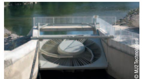
**Turbine ichtyocompatible à basse chute VLH.**
