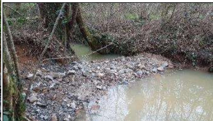
Figure 11 : radier court de la tranche n°1
