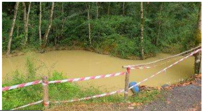
Figure 38 : système pour la décantation de l'eau au niveau des travaux de la déviation
