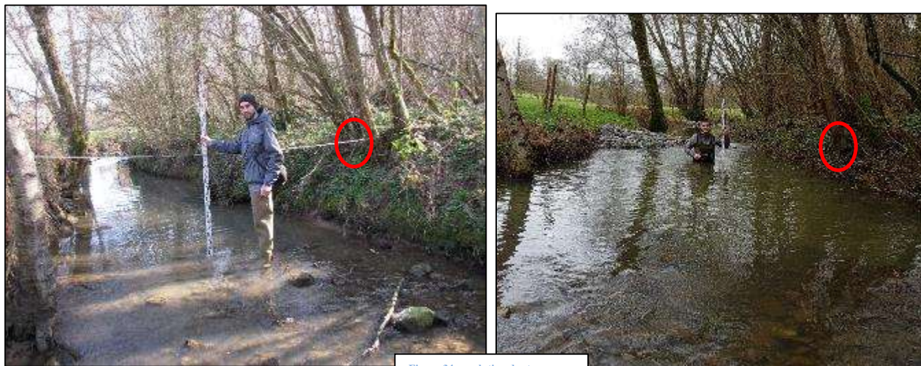
Figure 34 : evolution des travaux
