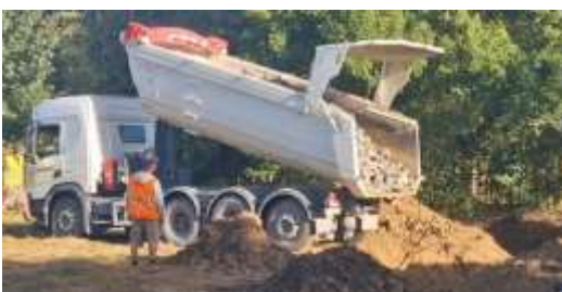
Figure 60 : camions faisant l'aport des matériaux
