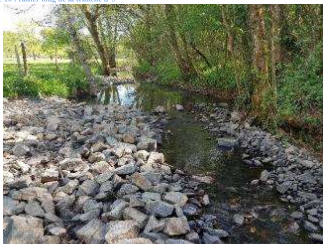
Figure 10 : radier long de la tranche n°3
