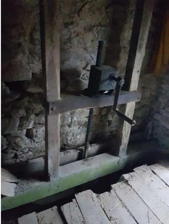
La vanne de chambre d'eau permet le fonctionnement de la turbine alimentant la scierie. Elle est fonctionnelle et se situe au sein du bâtiment abritant la scierie.
