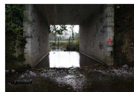
après travaux : recharge dans la fosse de dissipation
