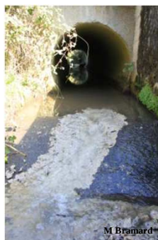
M Bramard Encoche rugueuse pour concentrer des écoulements
