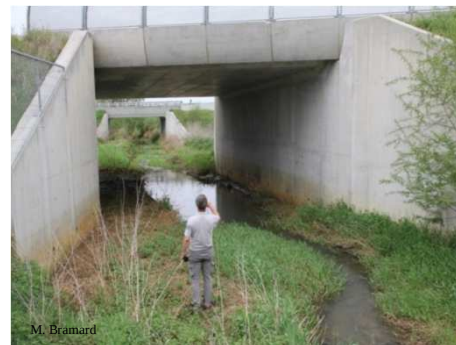
Surdimensionnement de lit, mais resserrement partiel consécutif à la fixation naturelle des sédiments atterris par les végétaux en dehors d'un OH
