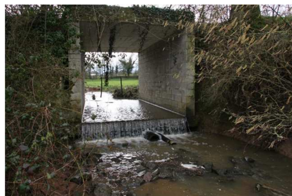
Pas d'écoulement préférentiel : faible lame d'eau + déchaussement aval
