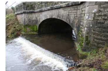
radier de pont restauré avec une rehausse en béton
