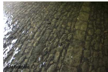
radier de pont ancien en bon état
