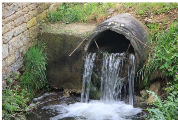
buse perchée, à demi bouchée par une planche et branchages...
