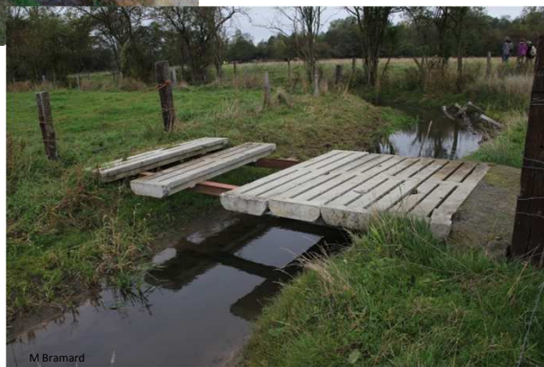
passerelle anti passage bovins
