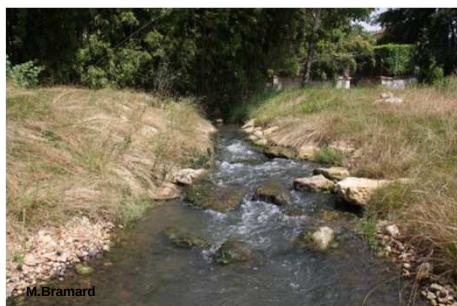
section amont d'une rivière de contournement bien dimensionnée
