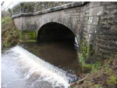
1-a : L'ouvrage est-t-il calé trop haut, y-a-t-il eu une réhausse du radier de l'ouvrage ?
