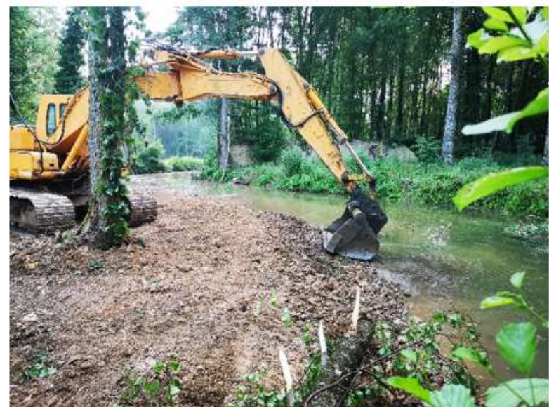
Photos : Réduction du gabarit de l'Auxance par aménagement de banquettes en terre/pierres et aménagement de radiers
