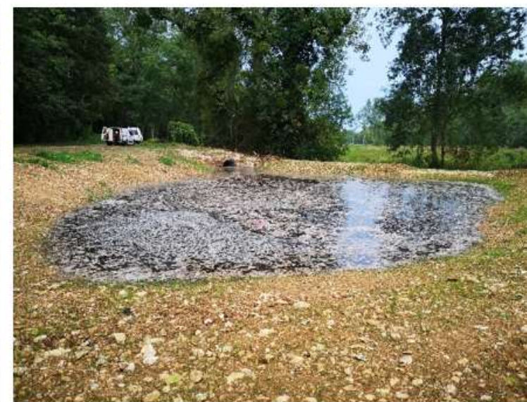
Photos : Aménagement d'un bassin de récupération des eaux pluviales avec rejet en zone humide
