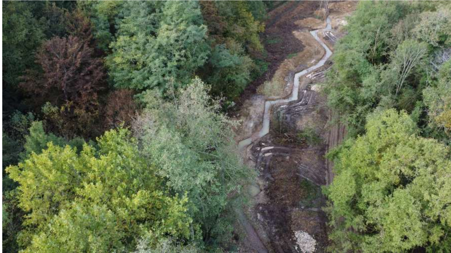
Travaux de remise en fond de vallée du ruisseau de la Torchaise - 2023
