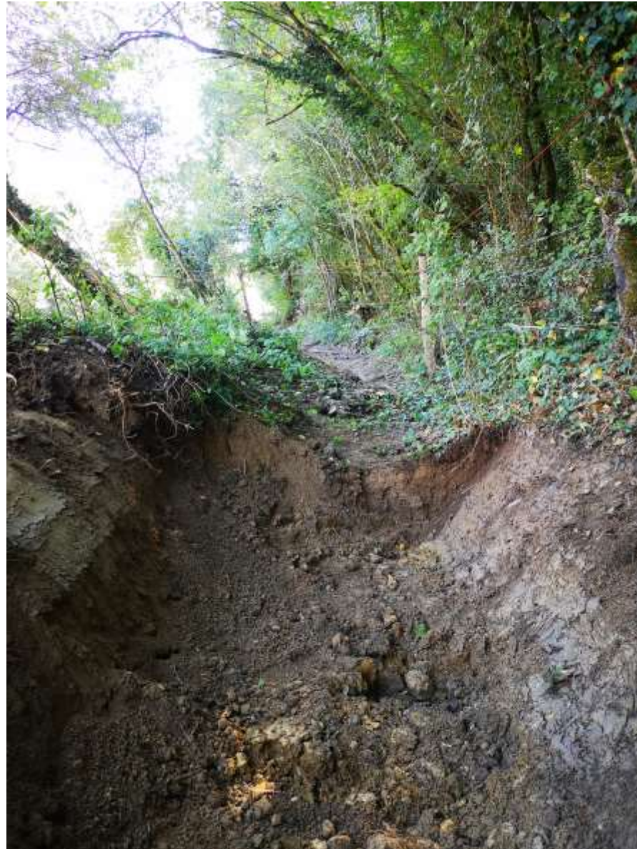
Enlèvement du substrat jusqu'à la couche d'argile de fond
