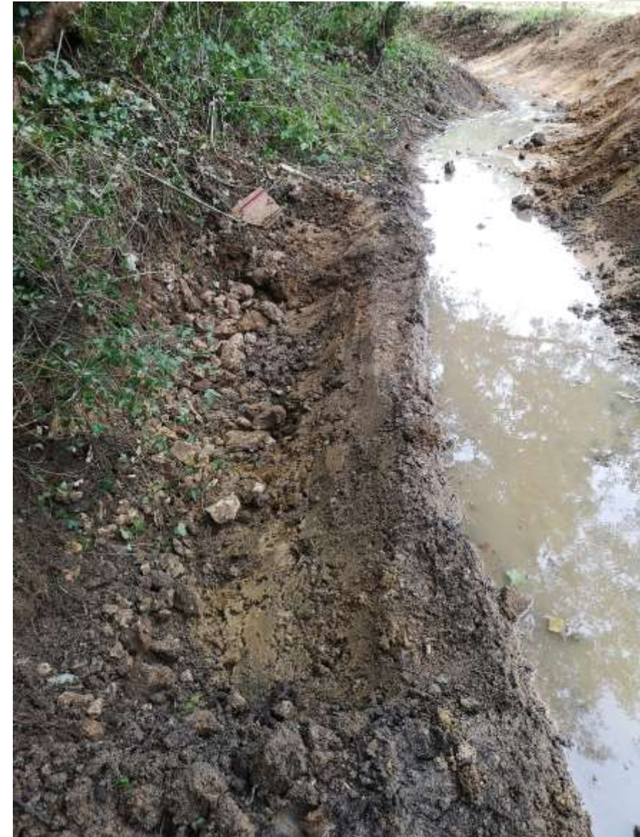
Purge de la zone d'infiltration principale
