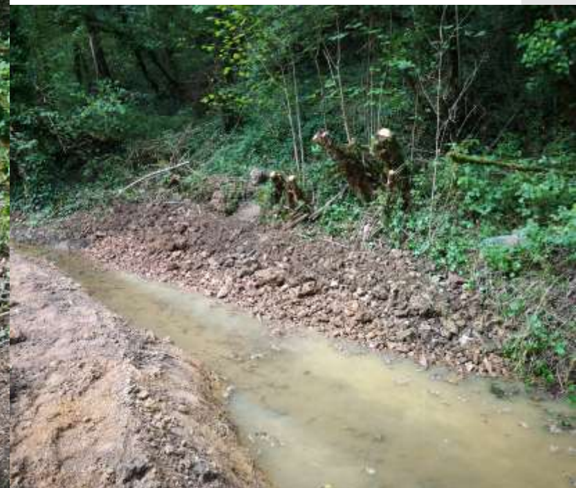
Apport d'une couche d'argile + d'alluvionnaire brute de carrière (50 % de sable) + PDC + Terre en HB
