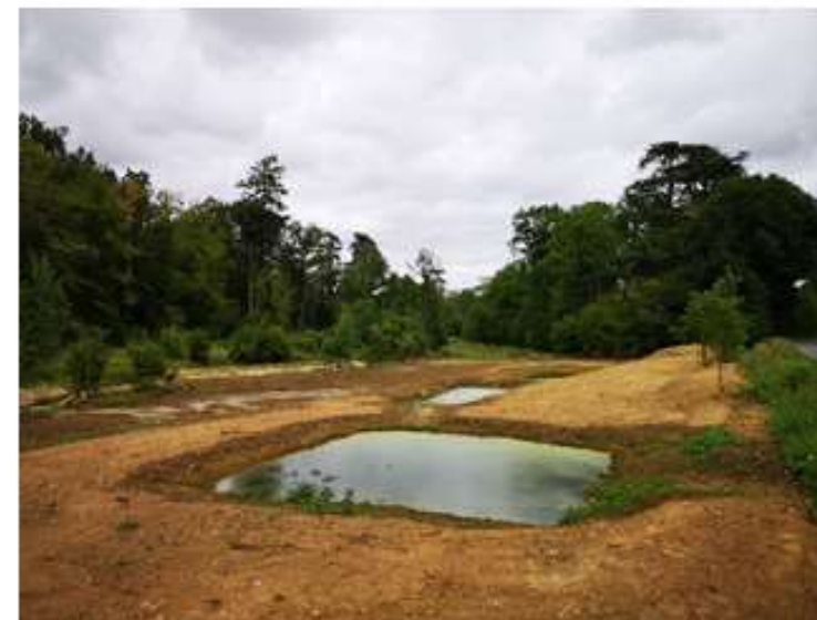
Terrassement et évacuation des remblais hors zone humide et aménagement de noues hors zone inondable récupérant les eaux traitées de la STEP (juillet 2022)
