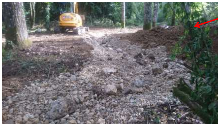
Le gouffre s'étant agrandi, il a été décidé de déplacer le cours d'eau pour éviter cette zone.
