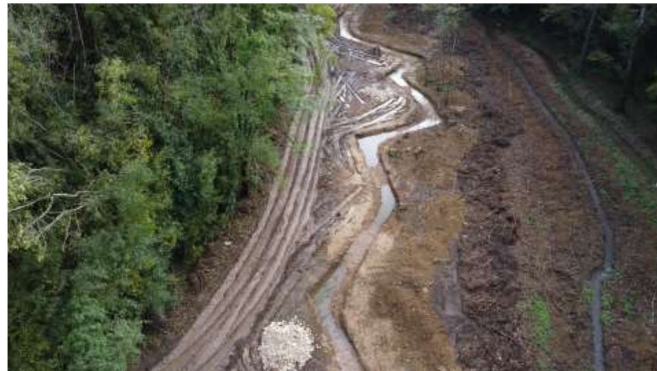
Arrêt du chantier suite aux fortes intempéries
