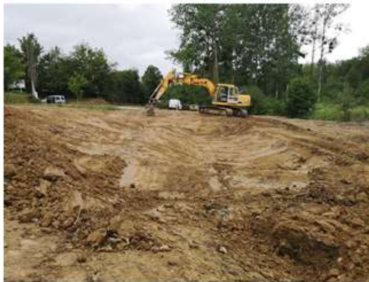
Terrassement et évacuation des remblais hors zone humide et aménagement de noues hors zone inondable récupérant les eaux traitées de la STEP (juillet 2022)
