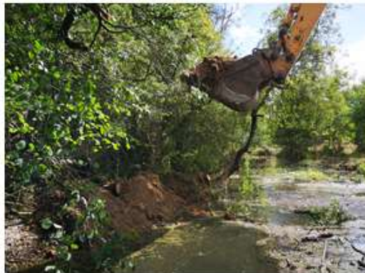
Pincement du lit de la Boivre avec les matériaux terreux issus de l'étrépage de la zone humide
