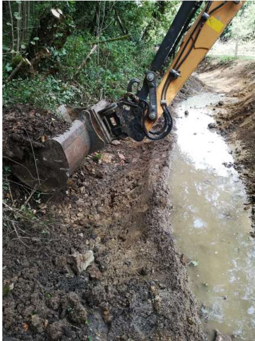
Purge de la zone d'infiltration principale
