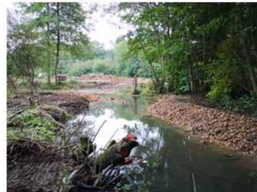
Mise en place d'un cordon de pierres de champs de protection en pied de berge
