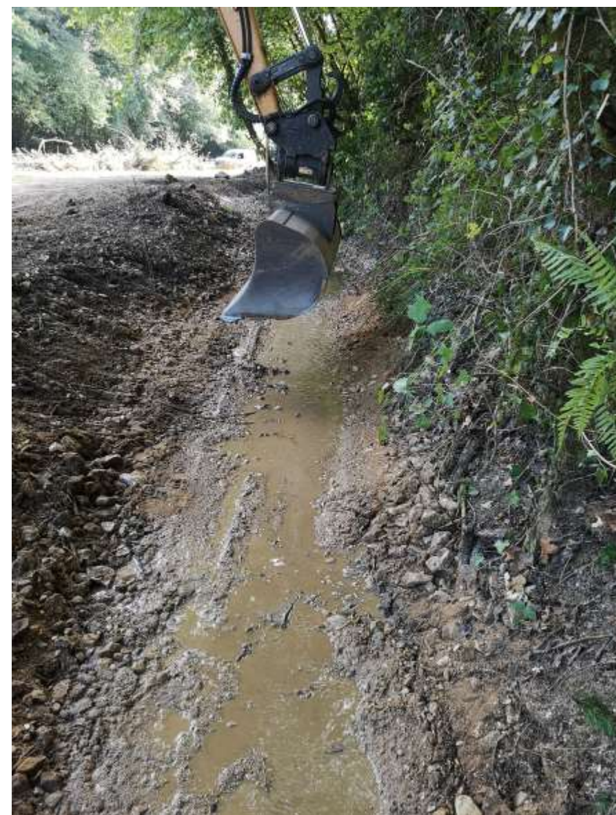
Enlèvement des matériaux mis en place
