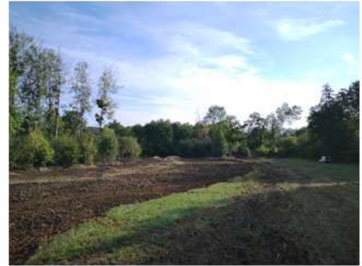
Etrépage de la zone humide en rive gauche de la Boivre pour augmenter la période d'immersion
