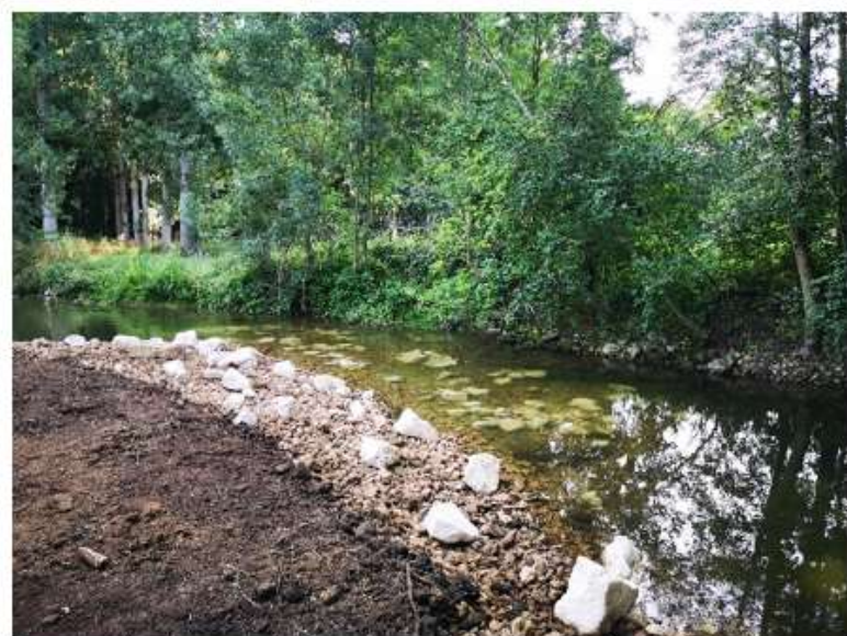
Photos : Réduction du gabarit de l'Auxance par aménagement de banquettes en terre/pierres et aménagement de radiers
