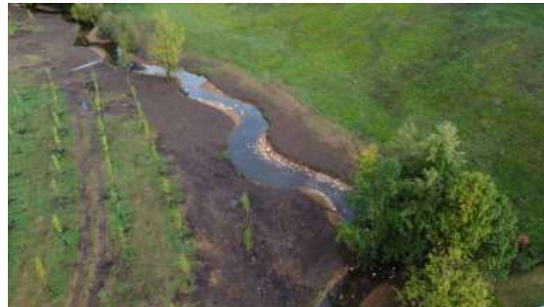
Secteur à l'amont du seuil après travaux
