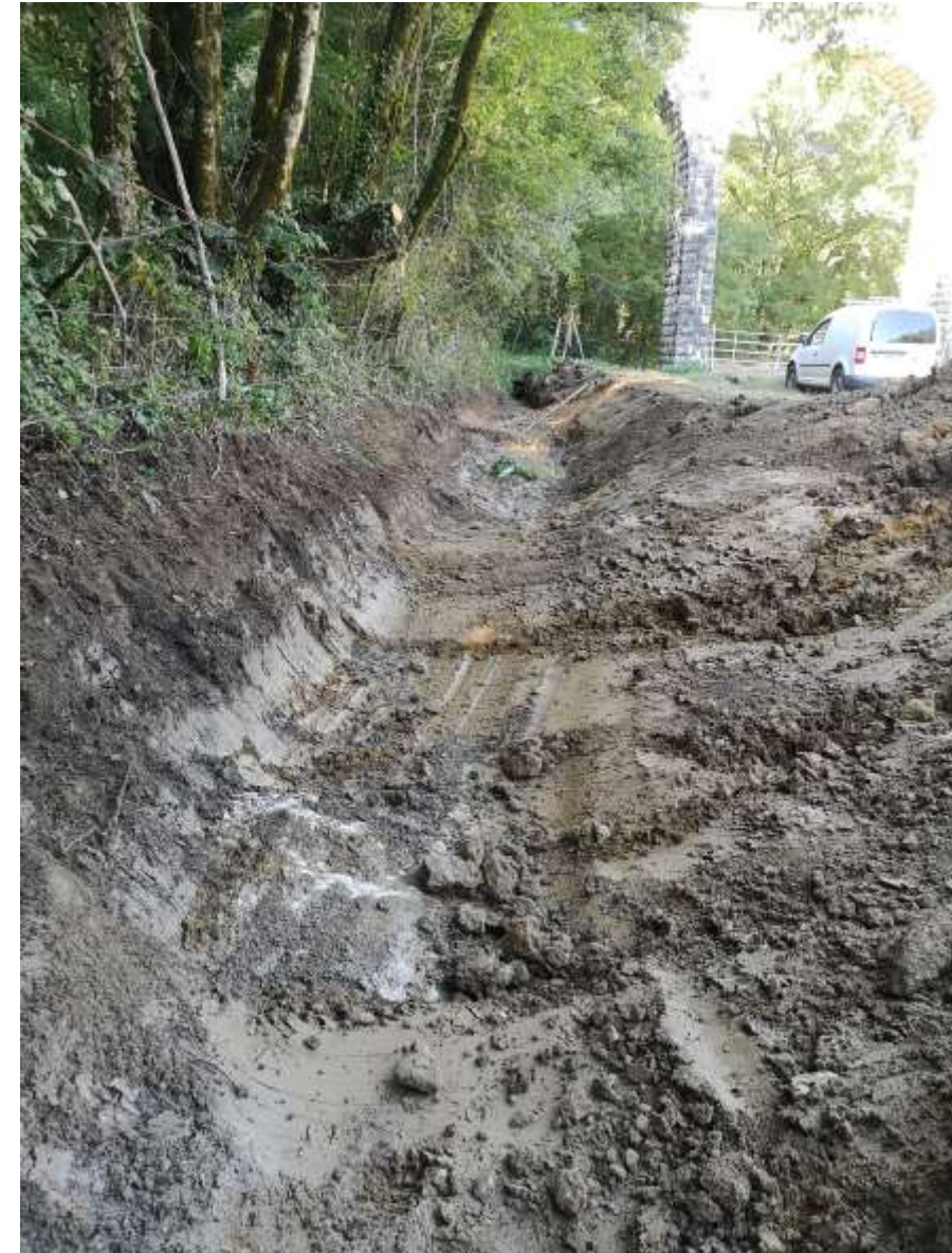
Enlèvement du substrat jusqu'à la couche d'argile de fond
