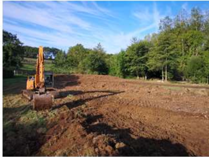
Etrépage de la zone humide en rive gauche de la Boivre pour augmenter la période d'immersion
