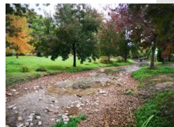
Secteur médian après travaux
