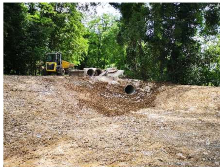
Photos : Aménagement d'un bassin de récupération des eaux pluviales avec rejet en zone humide
