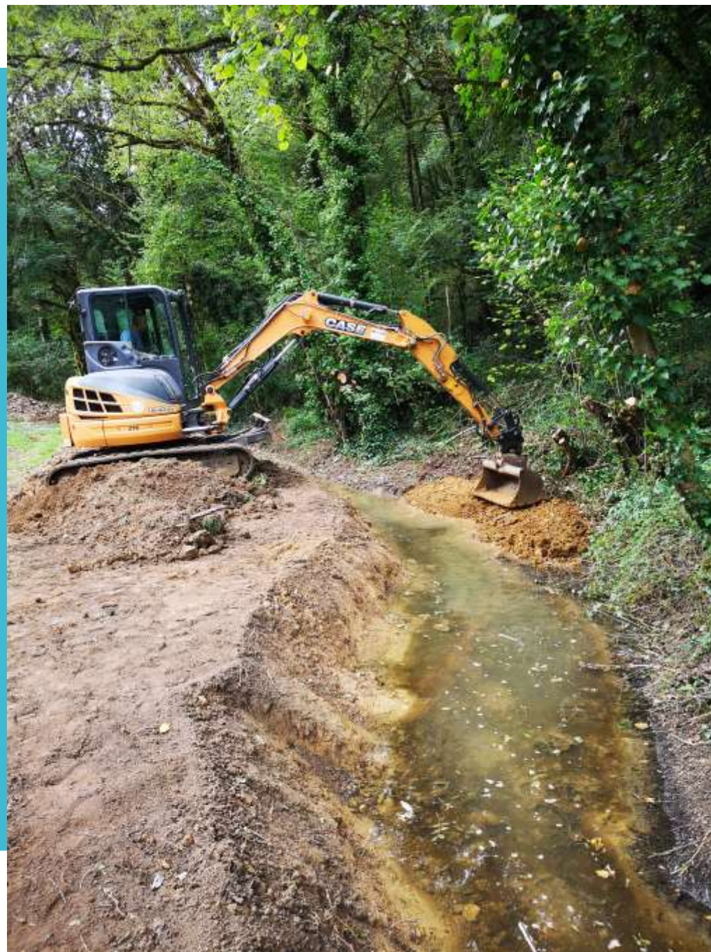
Apport d'une couche d'argile + d'alluvionnaire brute de carrière (50 % de sable) + PDC + Terre en HB
