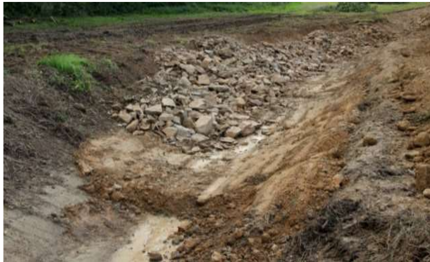
Initialement, un apport d'argile et la reconstitution du matelas alluvial était prévu au niveau de l'infiltration (photo Michel BRAMARD)
