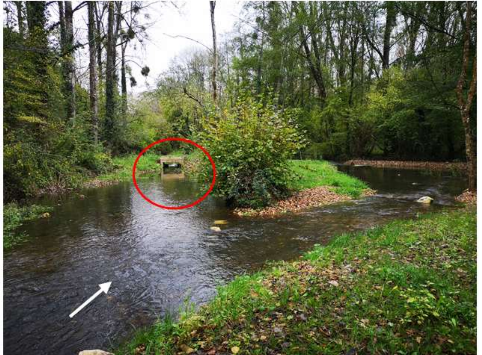
Dalot préfabriqué installé à l'entrée du canal d'amenée du moulin limitant les débits et le dépôt de MES
