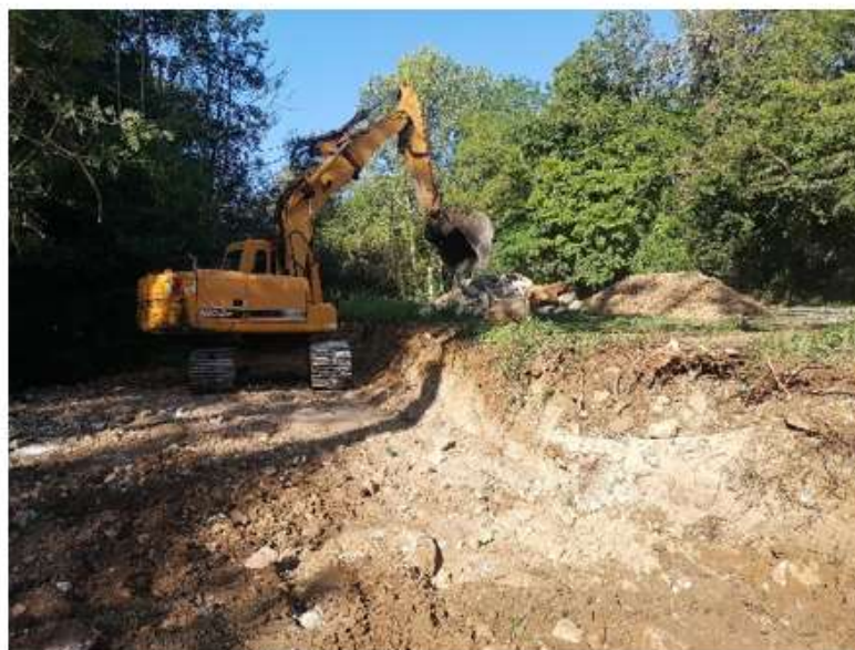
Photos : Récupération de remblais en zones humides
