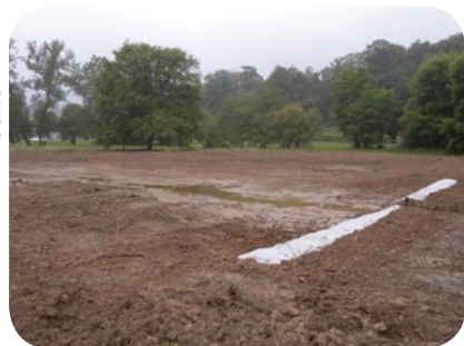
Réalisation du bassin aval de décantation
