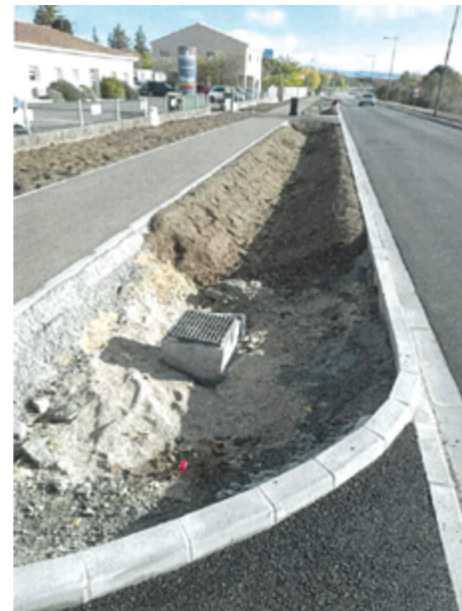
Noue "en chantier" sur une voirie communautaire. Le projet prévoyait initialement une canalisation. Il a été revu après une remontée d'information par la Direction cycle de l'eau. Le milieu récepteur en aval (un ruisseau) n'étant pas en mesure d'absorber les volumes d'eaux pluviales rejetés par le réseau, il déborde régulièrement et cause des inondations. Cette information avait été portée à sa connaissance par le syndicat GEMAPI plus tôt dans l'année. Cette modification a permis de diminuer l'impact du projet et ainsi de ne pas aggraver une situation d'inondation existante.
