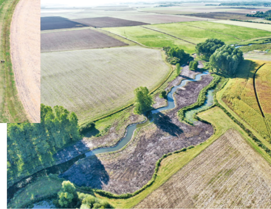
La Cisse après travaux de restauration. Un nouveau tracé plus sinueux et resserré, la Cisse remise dans son fond de vallée. Le ruisseau Azin se jette dans une confluence désormais morte qui fait office de ZHTA.
