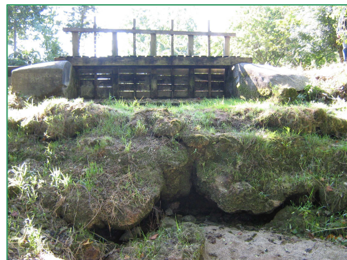
Vue aval de la vanne en août 2006 (photo : UNIMA)
