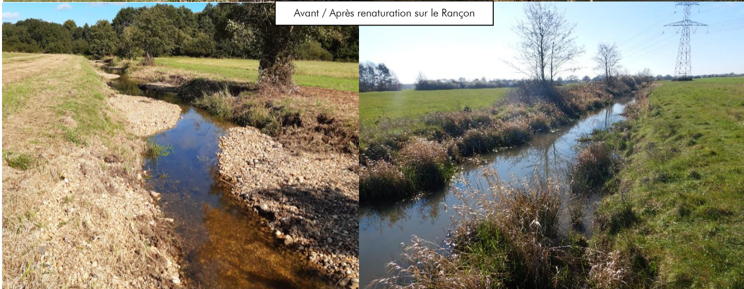
Avant / Après retalutage
