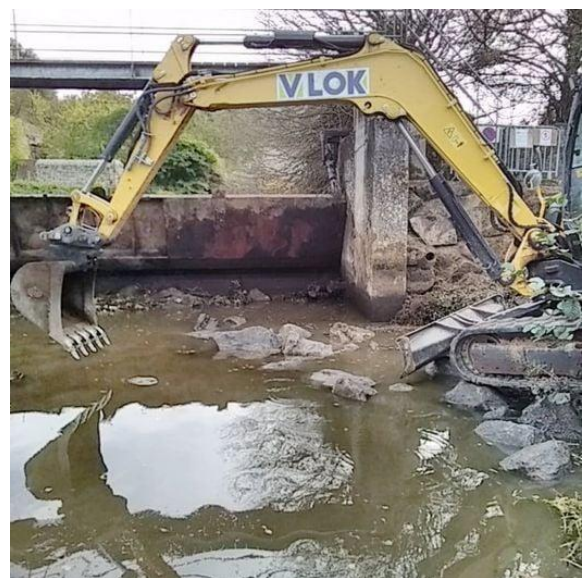
En travaux (clapet relevé)
