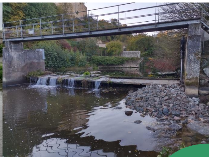
Mise en place des enrochements (passage rétabli)
