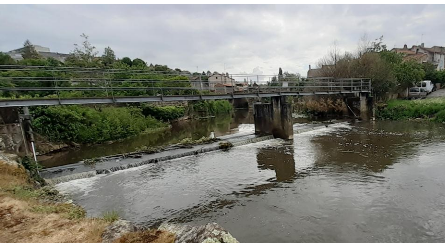
Le barrage de Saint-Paul avant travaux et son contexte urbain (infranchissable pour le castor)
