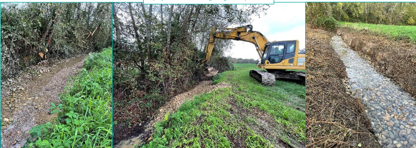
Aperçu travaux de recharge en granulat par dôme
