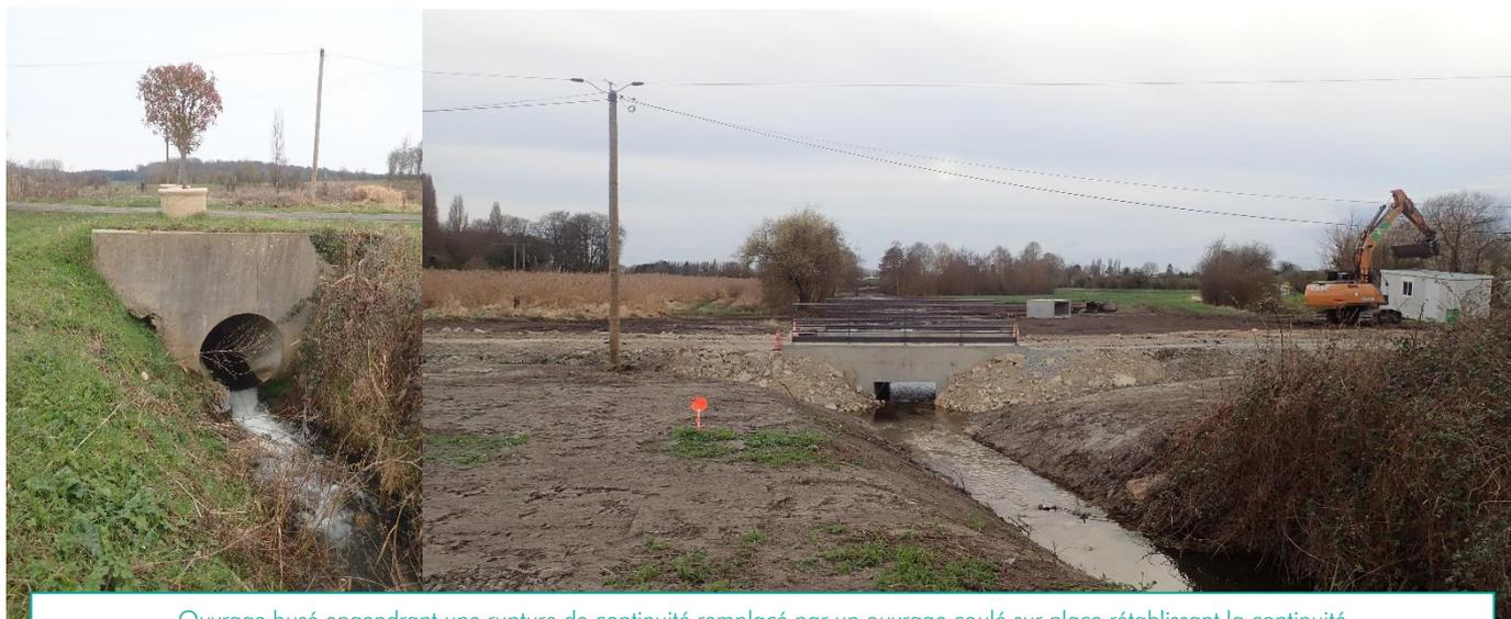
Ouvrage busé engendrant une rupture de continuité remplacé par un ouvrage coulé sur place rétablissant la continuité
