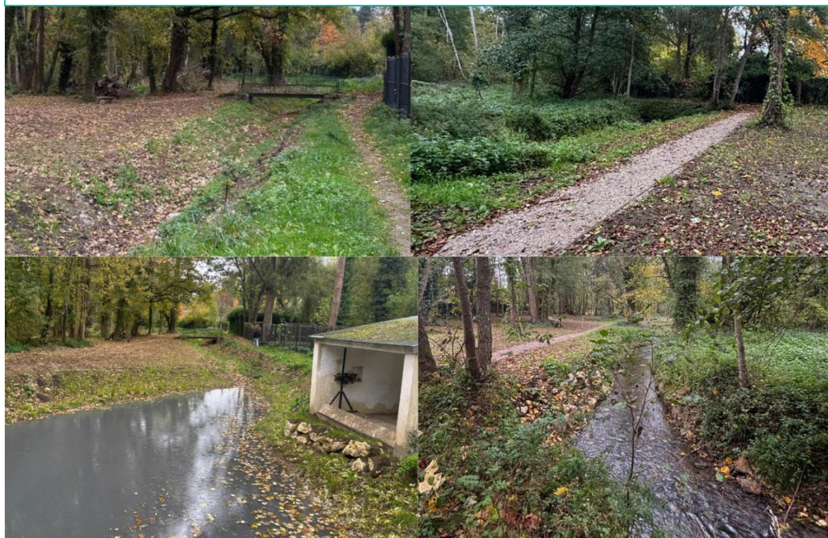
Photos après travaux (Octobre 2025) : A gauche : L'ancienne Drouette convertie en noue végétalisée, réceptacle des eaux pluviales alimentant la mare aménagée A droite : La Drouette restaurée en fond de vallée dans son cours naturel et bordée par un sentier pédestre
