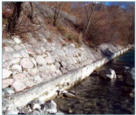
Figure 4.38. Arbres et arbustes installés sur le perré jointoyé de la digue rive droite du Guil à Eyglies (05), sans indice majeur de déstructuration (ph. P. Mériaux).
