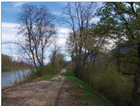
Figure 3.3. Digue de l'Isère alternant des zones herbacées sur des talus récemment rénovés, des bouquets d'arbres résiduels, des fourrés denses d'arbustes et de rejets d'arbres coupés (ph. C. Zanetti).
