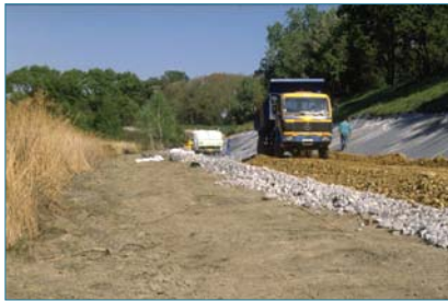
Figure 4.35. Recharge aval partielle sur drain-filtre géocomposite créée sur la digue rive gauche du Petit Rhône à Tringuetaille-Cazeneuve suite à la crue du 8 janvier 1994. (a) Coupe schématique (figure P. Mériaux/Irstea). (b) photos des travaux et du confortement terminé (photos P. Mériaux).
