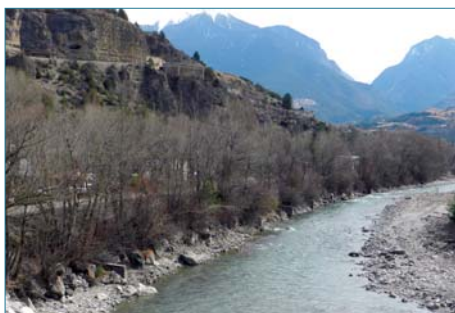
Figure 5.8. Corridor de peupliers quinquagénaires s'étant installés sur les enrochements de protection du parafouille béton. Épis en béton déchaussés par l'incision du Guil (ph. P. Mériaux).
