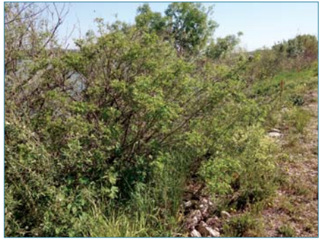
Figure 3.18. Couvert arbustif dense gênant l'inspection visuelle. Le retour à une situation satisfaisante (type 2) peut être rapide et n'impose pas de travaux de réfection du remblai (ph. M. Vennetier).
