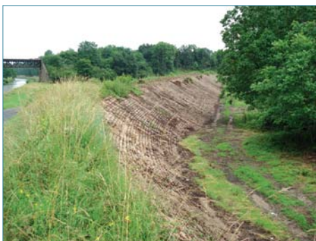
Figure 3.5. Digue de la Loire avec perré maçonné. Noter les rejets de souche d'arbres poussant directement dans le perré et récemment coupés (ph. C. Zanetti).
