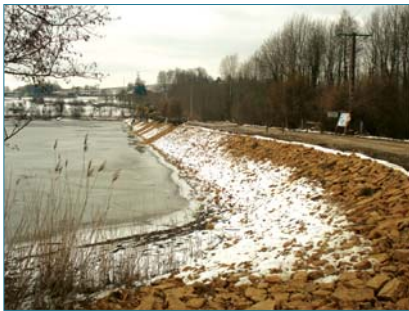
Figure 5.26. Parement amont après les travaux de reprise de la protection anti-batillage (2010) (ph. Cemagref/Irstea).
