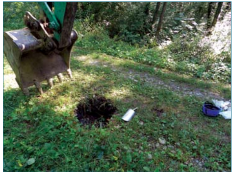
Figures 4.8. Fontis d'origines différentes sur une crête de digue résultant : (a) d'écoulements internes lors d'une crue récente (photo prise lors d'un examen visuel post-crue), (b) de la probable décomposition d'une grosse souche pour cette digue située en environnement boisé (photos P. Mériaux).
