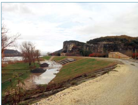
Figure 5.24. Actuellement, après la réalisation du confortement de la digue (ph. CNR/EDF).
