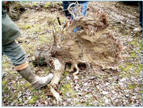
Figure 3.11. Pivot et ses ramifications en forme de raquette plate ayant colonisé une faille de compactage sur une digue (dimensions 100 x 80 x 10 cm). Le phénomène a été découvert lors de la tempête de 1999 : tous les arbres tombés avaient un enracinement très superficiel s'arrêtant à 20 cm de profondeur au niveau du matériau compacté ; tous les arbres restés debout avaient ce type de pivot colonisant sur 1 à 2 m de profondeur de minces bandes verticales mal compactées (ph. C. Ripert).
