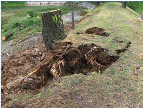
Figure 1.19. Système racinaire d'un mélèze ayant destabilisé une digue sur plus de la moitié de sa largeur. Certaines grosses racines s'enfoncent profondément au cœur de l'ouvrage (ph. Zanetti C.).
