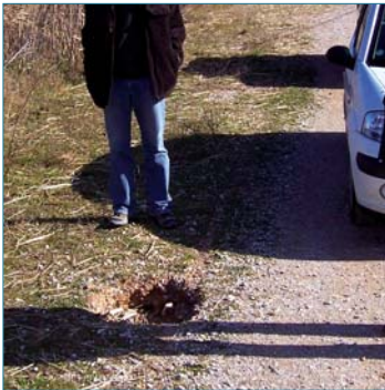
Figures 4.8. Fontis d'origines différentes sur une crête de digue résultant : (a) d'écoulements internes lors d'une crue récente (photo prise lors d'un examen visuel post-crue), (b) de la probable décomposition d'une grosse souche pour cette digue située en environnement boisé (photos P. Mériaux).
