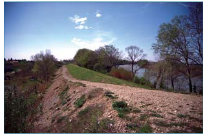
Figure 4.35. Recharge aval partielle sur drain-filtre géocomposite créée sur la digue rive gauche du Petit Rhône à Tringuetaille-Cazeneuve suite à la crue du 8 janvier 1994. (a) Coupe schématique (figure P. Mériaux/Irstea). (b) photos des travaux et du confortement terminé (photos P. Mériaux).
