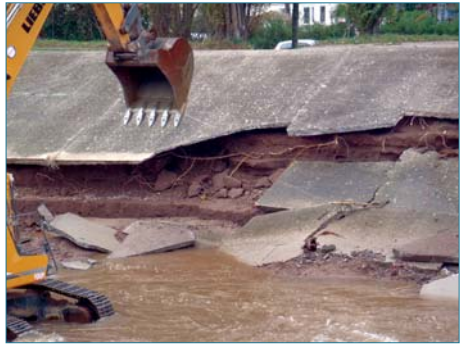
Figure 4.32. Mise en évidence de racines traçantes en sous-face de perré sur la digue du Reyran, suite à la crue de novembre 2011 (ph. G. Degoutte, Irstea/CGAER).
