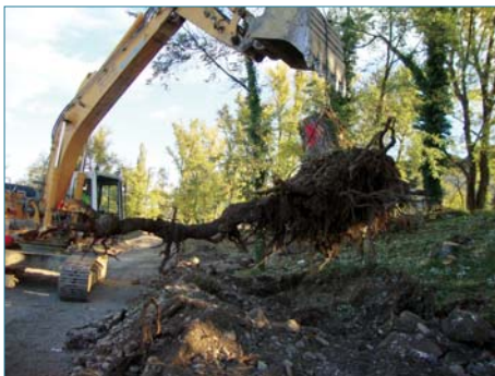
Figure 5.23. Pendant les travaux de dessouchage (ph. C. Zanetti).
