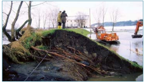
Figure 1.17a. Sur la gauche de cet arbre en cours de dégagement, une énorme racine (diamètre 25 cm, flèche blanche) s'enfonce en plongeant vers le cœur de la digue. Sa taille, surdimensionnée par rapport aux autres racines, indique qu'elle a probablement atteint le sol et la nappe sous le remblai ou de l'autre côté de l'ouvrage et joue un rôle clef dans l'alimentation de l'arbre. Sa décomposition laisserait une galerie de gros diamètre dans la digue (ph. C. Zanetti). Figure 1.17b. L'érosion de cette digue du Danube, lors des crues de 1988, révèle des racines venant des arbres visibles à gauche, et ayant traversé le remblai de part en part à la recherche de l'eau du côté rivière. On notera le fort diamètre d'une des racines relativement à celui des troncs. Le déracinement d'arbres proches de la crête a été à l'origine de plusieurs brèches au cours de cette crue (ph. C.H. Ifft, USACE).
