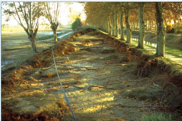
Figure 1.16. Développement de racines à l'interface entre la digue et le sol qui la porte, révélé par l'érosion du remblai lors d'une rupture. La présence d'un horizon humifère (ancien sol) non décapé à la construction, ou d'une nappe en provenance du canal alimentant le sol en eau sous l'ouvrage, peut favoriser ce développement. Le maintien d'une réserve d'humidité sous la digue, en raison de l'épaisseur du remblai qui limite l'évaporation profonde, peut aussi contribuer à de tels phénomènes dans les climats présentant une saison sèche (ph. P. Mériaux).
