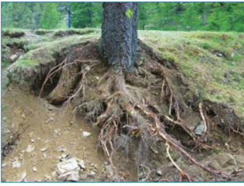
Figure 1.17a. Sur la gauche de cet arbre en cours de dégagement, une énorme racine (diamètre 25 cm, flèche blanche) s'enfonce en plongeant vers le cœur de la digue. Sa taille, surdimensionnée par rapport aux autres racines, indique qu'elle a probablement atteint le sol et la nappe sous le remblai ou de l'autre côté de l'ouvrage et joue un rôle clef dans l'alimentation de l'arbre. Sa décomposition laisserait une galerie de gros diamètre dans la digue (ph. C. Zanetti). Figure 1.17b. L'érosion de cette digue du Danube, lors des crues de 1988, révèle des racines venant des arbres visibles à gauche, et ayant traversé le remblai de part en part à la recherche de l'eau du côté rivière. On notera le fort diamètre d'une des racines relativement à celui des troncs. Le déracinement d'arbres proches de la crête a été à l'origine de plusieurs brèches au cours de cette crue (ph. C.H. Ifft, USACE).
