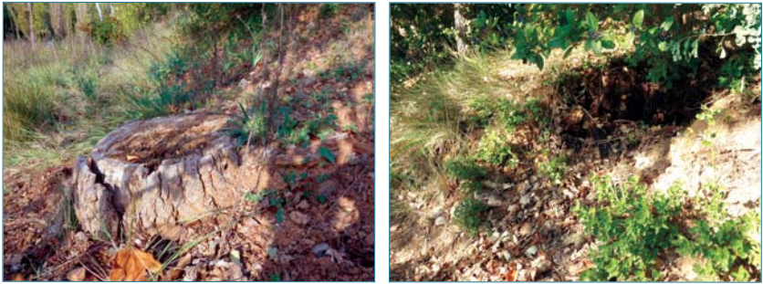
Figure 4.9. Souches pourrissantes au pied d'un talus de digue. (a) Dans une première étape, la souche est encore visible. (b) Dans une deuxième étape, la souche pourrissante provoque un petit effondrement local et un début d'érosion. Des tourbillons en cas de crue peuvent surcreuser cette encoche dans le talus (digue de protection, talus côté cours d'eau). Dans une troisième étape, il ne restera peut-être qu'une irrégularité dans la surface du talus, mais si la souche était grosse et profonde, cette zone sera durablement fragilisée. Elle pourra donner lieu à un fontis (fig. 4.8), favoriser une érosion importante du talus lors d'une crue, ou faciliter une érosion interne (photos M. Vennetier).
