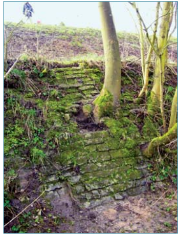
Figure 4.11. Arbres commençant à détruire un ouvrage de protection de berge en maçonnerie de pierres (ph. P. Mériaux).
