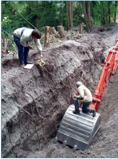
Figure 3.12. Les racines des arbres poussant sur les parements ont envahi, sur toute sa hauteur, cette digue ancienne non compactée. Certaines la traversent de part en part, profitant d'horizons plus favorables liés à des rehaussements successifs qui sont visibles dans la stratification des matériaux (ph. G. Doirat).
