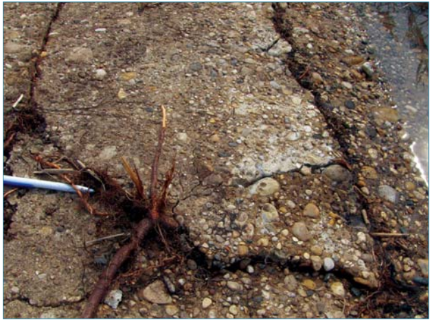
Figure 1.1. Dégradation d'une dalle béton par des racines d'arbuste ayant colonisé une fissure (ph. C. Zanetti).
