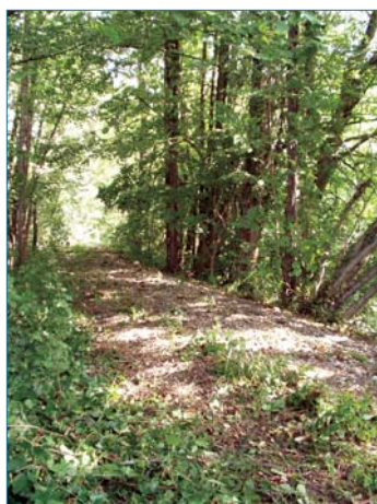
Figure 5.11. L'abandon de l'entretien courant des digues après 1970 avait conduit au développement d'une forêt luxuriante sur une grande partie des talus (ph. C. Ripert).
