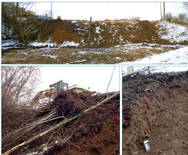
Figure 5.28. Déracinements d'arbres sur le parement aval et appréciation du développement racinaire dans les fouilles du futur évacuateur de crues (février 2010) (photos Cemagref/Irstea).
