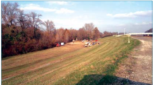
Figure 5.20. Après travaux de dessouchage (ph. EDF).
