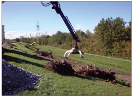
Figure 5.19. Pendant travaux de dessouchage (ph. C. Zanetti).
