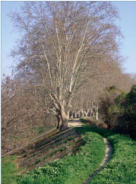
Figure 1.20. Alignement de platanes centenaires sur une crête de digues à charge temporaire. Un perré bétonné protège le talus côté fleuve mais il est par endroits soulevé par les racines. Le système racinaire de ces platanes occupe la totalité du corps de digue. Leur déracinement provoquerait une loupe d'arrachement au moins équivalente, en proportion, à celle de la figure 1.19 (ph. M. Vennetier).
