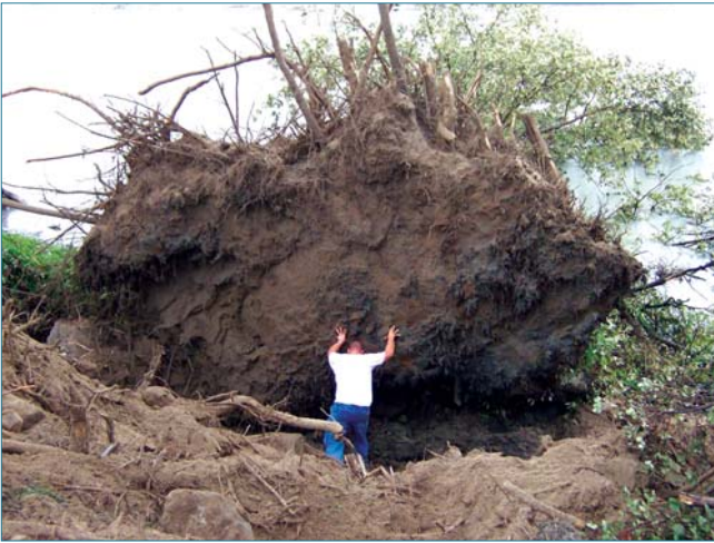
Figure 3.26. Peuplier déraciné sur une digue de protection contre les inondations en Californie, emportant une imposante masse de terre. Cette encoche pourra générer des tourbillons érosifs en cas de crue. Le déracinement a aussi totalement déstructuré les matériaux en surface du talus sur plusieurs dizaines de mètres carrés au-delà de la motte arrachée (au premier plan), et éparpillé les blocs d'un enrochement de surface à travers lequel il avait poussé. Le talus est donc, jusqu'à sa réfection, très vulnérable à l'érosion (ph. C. Iffr, USACE).
