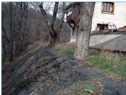
Figure 5.6. Peupliers en crête, à l'aplomb du masque en galets liés au bitume (ph. P. Mériaux).
