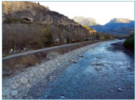
Figure 5.10. État immédiatement après travaux (lot aval). Les arbres du parement côté zone protégée de la digue sont conservés. À comparer avec la figure 5.8 (ph. P. Mériaux).
