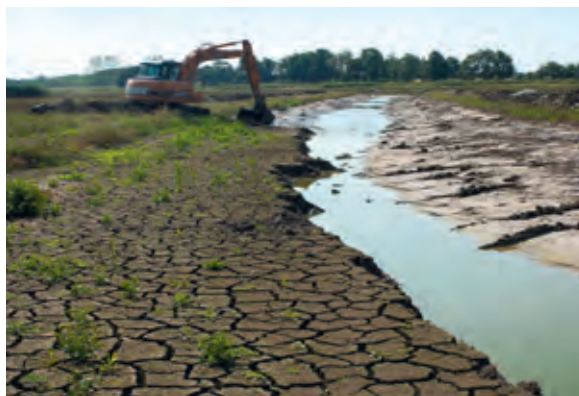
▲ L'assec est l'occasion de réaliser les travaux d'entretien de l'étang
