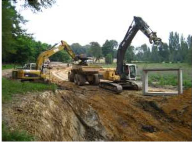
Terrassements pour la préparation de l'assise de la digue et de la pose du pont cadre
