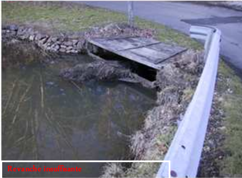
Absence dissipateur d'énergie
