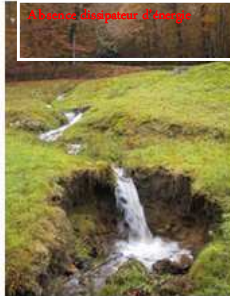
Erosion au déversoir
