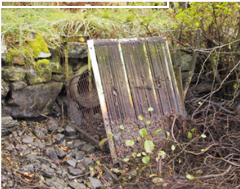
Revanche insuffisante Grilles bouchées
