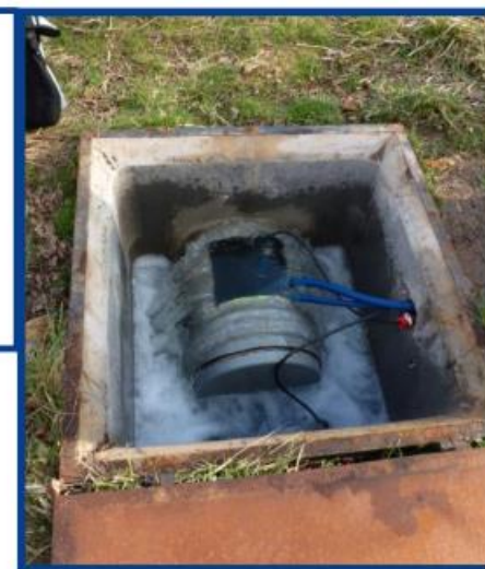
Ouvrage de vidange en sortie de zone humide avec Sondes de mesure et crépine de prélèvement
