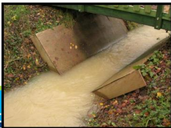
Station d'échantillonnage et de suivi du débit
